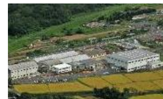
制御システム工場
