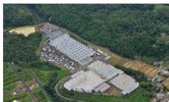
(右) 八田工場 (左) 本社工場
