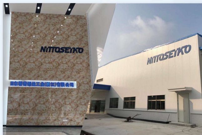
NPS 第二工場
