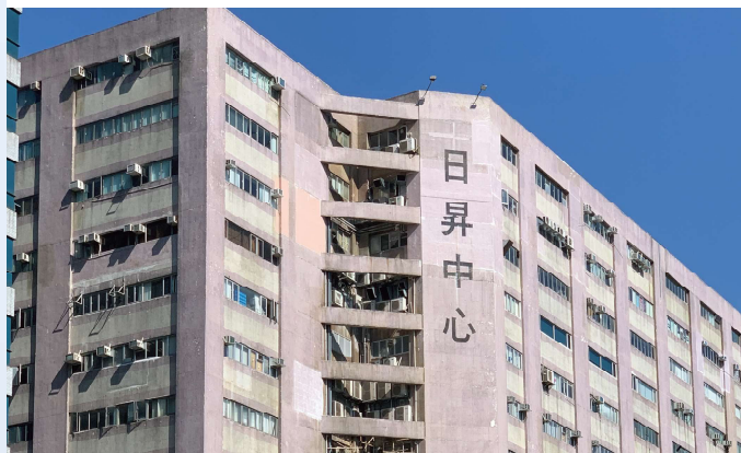
(上) 本社（群馬営業所）（下）香港和光精工有限公司
