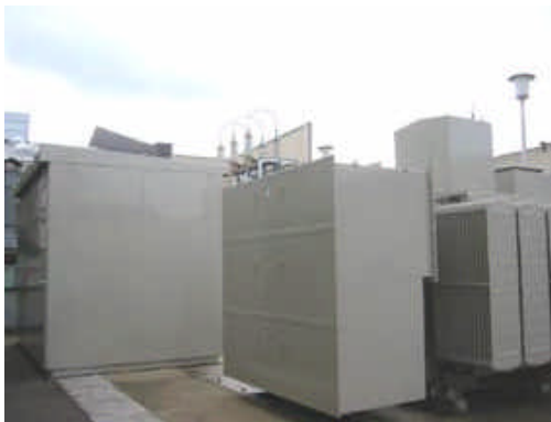
特別高圧受電トランスを更新し効率アップを図りました。
