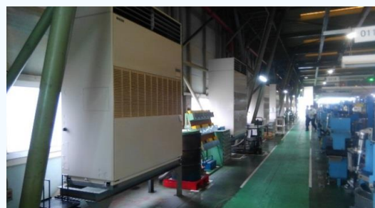
省エネ型空調機
